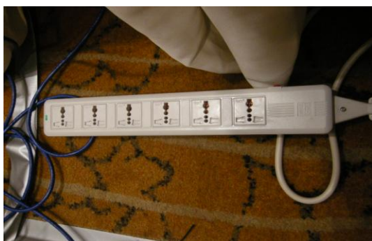
Terminal Room 電力插座
